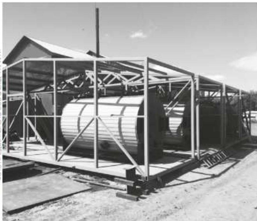
Изготовление блочно-модульной водогрейной котельной установки БМВКУ-3,0 МВт
